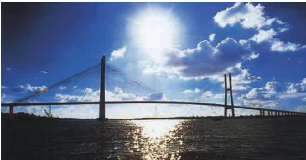
Hình 14.2. Cầu Mỹ Thuận bắc qua sông Tiền
