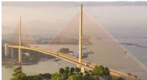
Cầu Bãi Cháy
