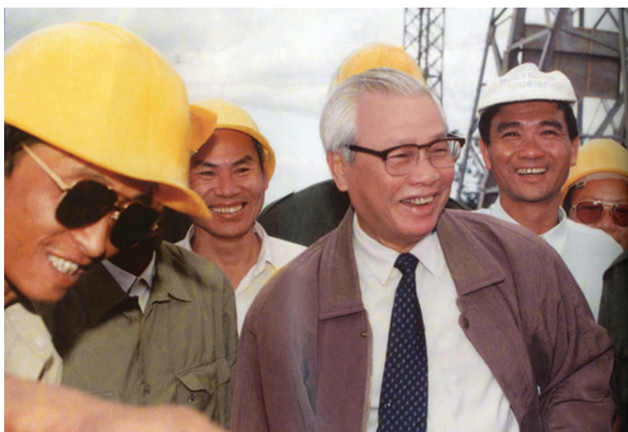
Thủ tướng Võ Văn Kiệt trên công trình xây dựng đường dây tải điện 500 kV Bắc - Nam đoạn đi qua Tây Nguyên
