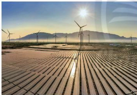
f) Trạm phát điện gió
