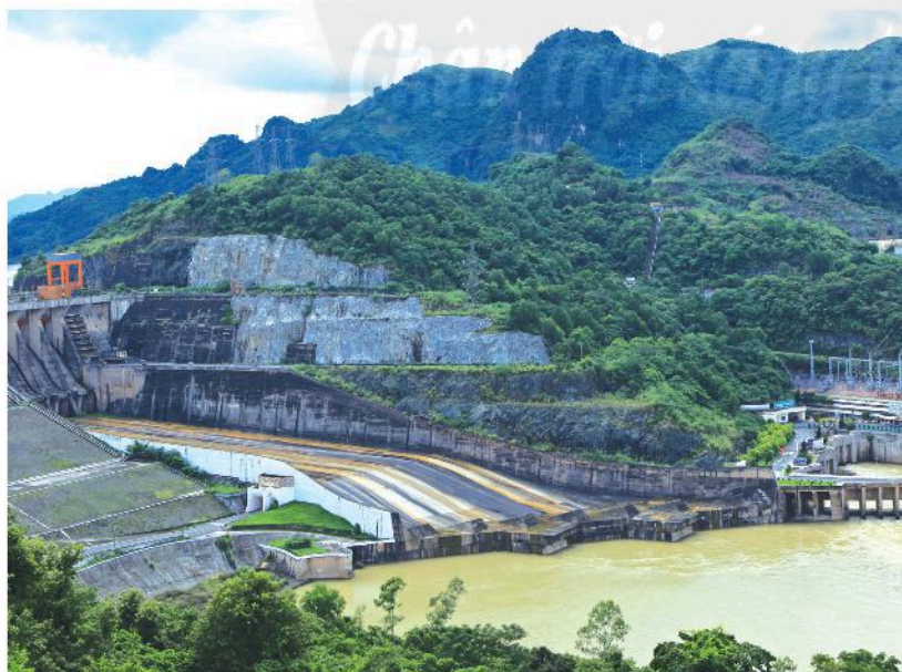
c) Nhà máy thủy điện (Hoà Bình)
