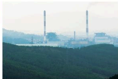
▲ Hình 10.8. Nhà máy nhiệt điện
