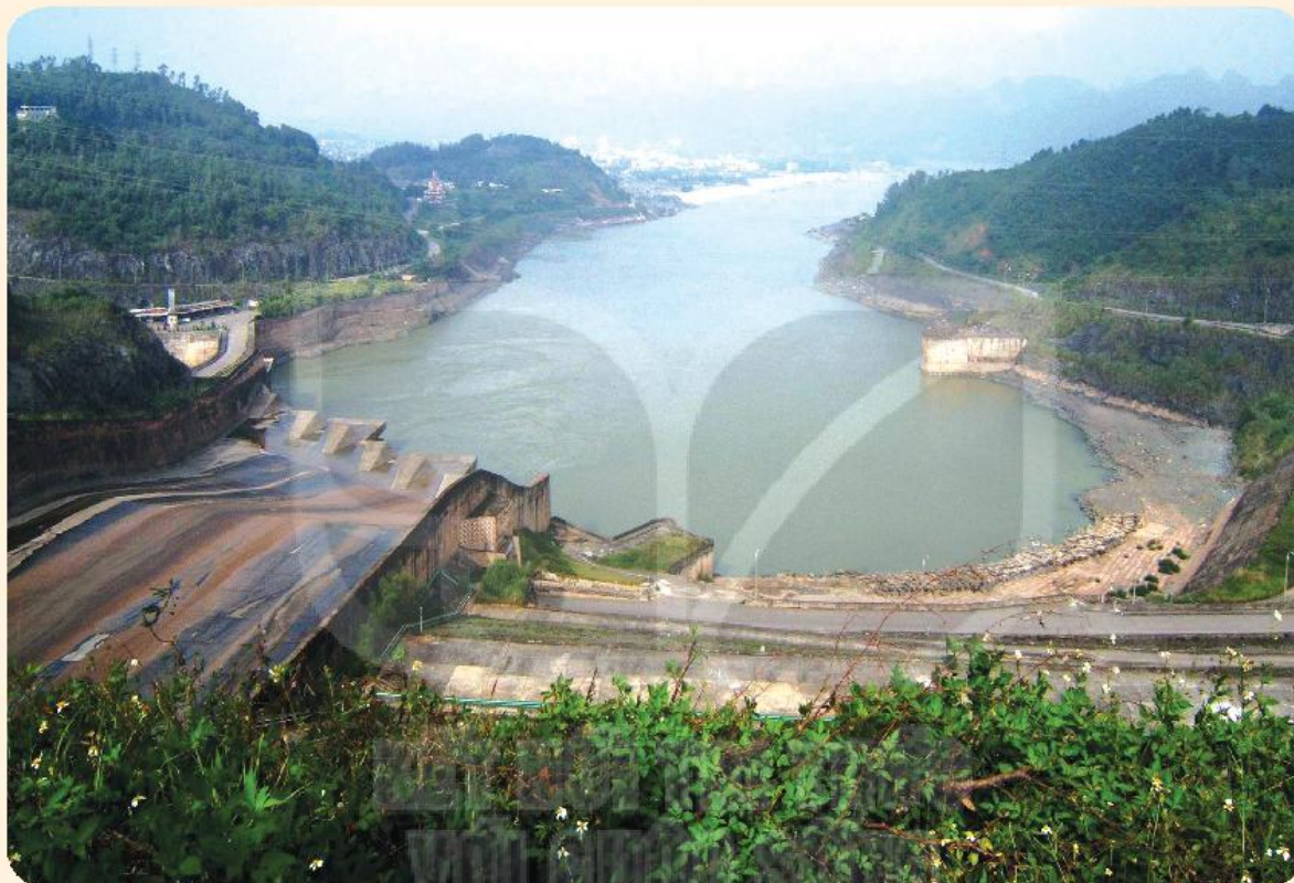
a) Đập thủy điện
