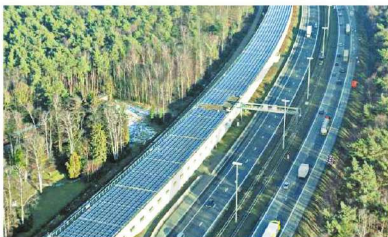
Hình 3.2. Một đoạn đường hầm năng lượng mặt trời nối liền Pa-ri (Pháp) với Am-xtéc-dam (Hà Lan)
