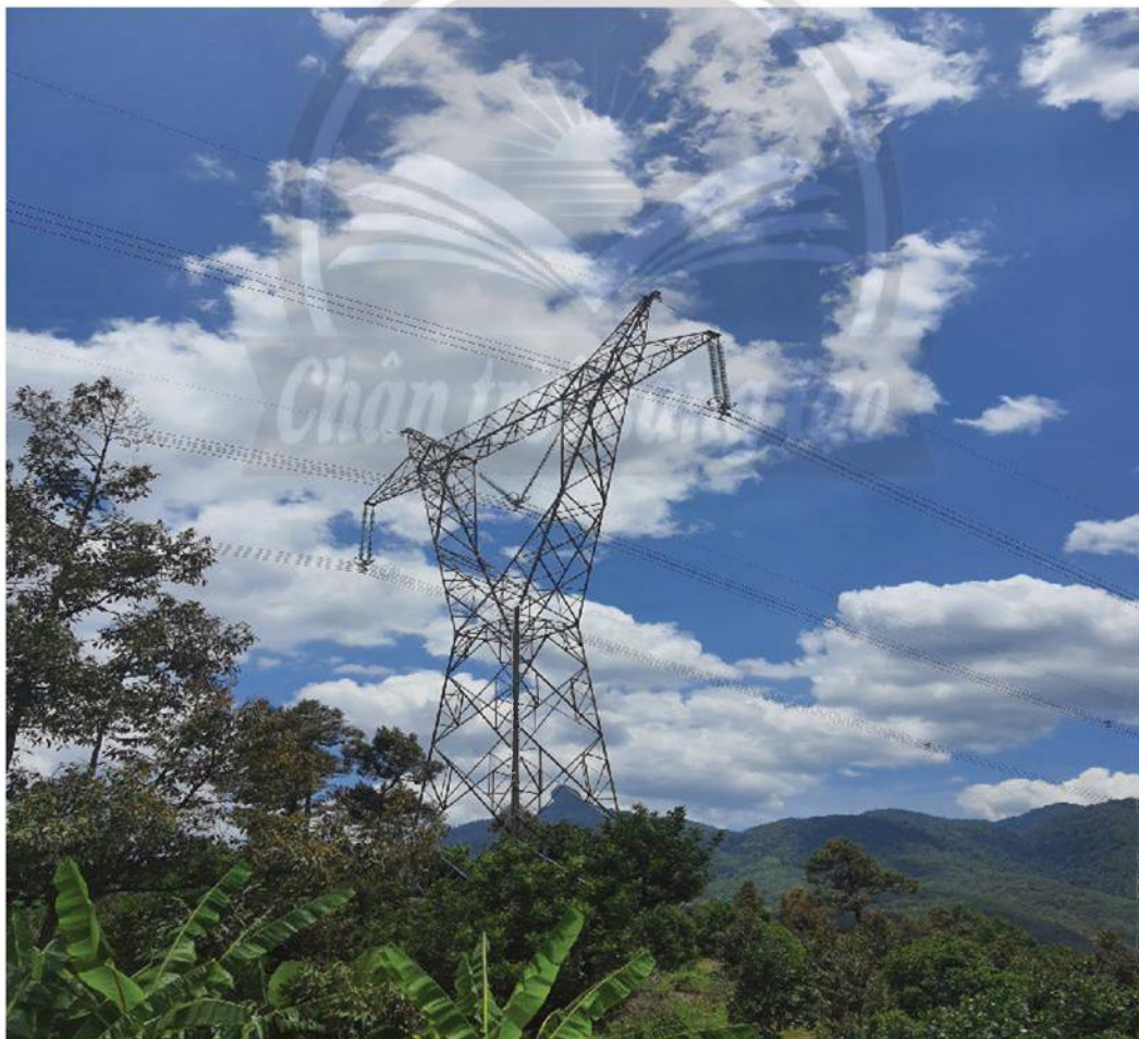
Các trụ điện trong đường dây 500 kV có nhiều kết cấu hình tam giác.
