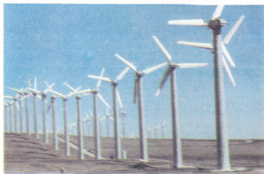
Hình 32.3. Trạm phát điện năng lượng gió
