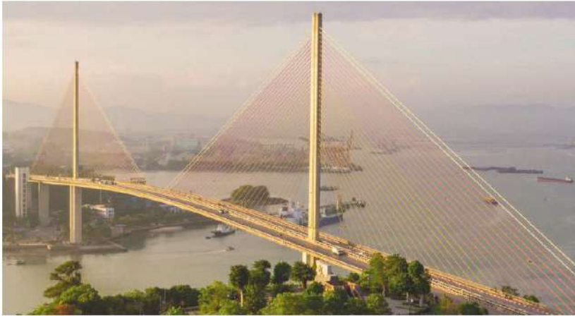
Cầu Bãi Cháy
