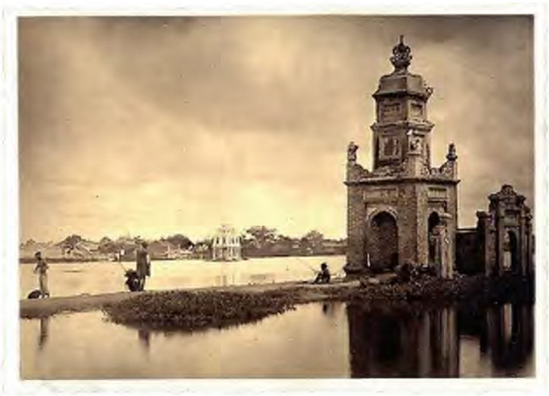
Tháp Hòa Phong
