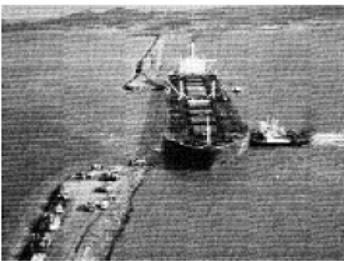
Năm 1984. Dự án ngăn đập chắn sóng với phương pháp “Tận dụng tàu chở dầu”, còn gọi là “Phương pháp Chung Ju Yung”.
