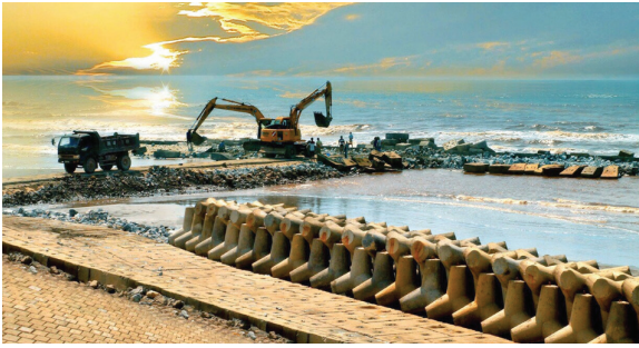
Hình 17.4. Xây kè bờ biển ở Giao Thủy (tỉnh Nam Định)
