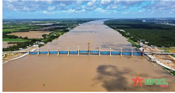
Hình 17.5. Hệ thống thủy lợi Cái Lớn – Cái Bé ngăn mặn, kiểm soát nguồn nước (tỉnh Kiên Giang)
