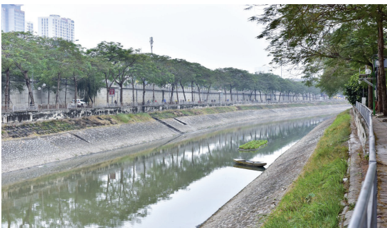
Hình 8.9. Một đoạn sông Tô Lịch sau khi được xử lý
