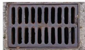
▲ Hình 18.3. Lưới chặn rác làm bằng gang
