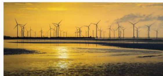
▲ Hình 15.2. Nhà máy điện gió Bạc Liêu
