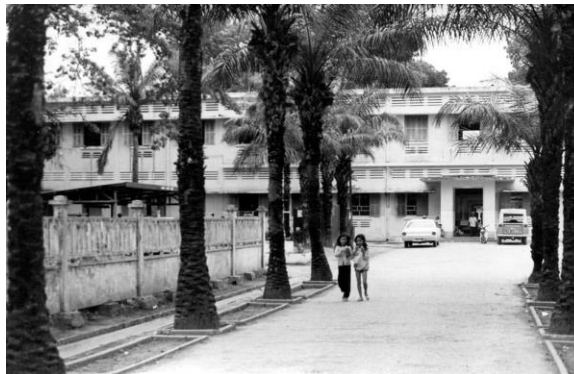
Hình 14: Nhà Thương Thí Nguyễn Trung Trực Vĩnh Long năm 1955, ảnh Công Báo VNCH 1955 (Administrative Bulletin of RVN 1955).
