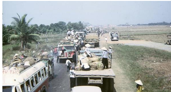
Hình 19: Một bên đầu cầu Bến Lức bị kẹt do cây cầu huyết mạch bị đặt mìn năm 1966, nguồn Công Báo VNCH 1966 (Administrative Bulletin of RVN 1966).
