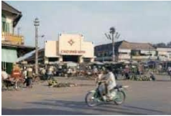
Hình 2: Chợ Phú Vinh (Tra Vinh) năm 1972, Công Báo VNCH 1972 (Administrative Bulletin of RVN 1972).
