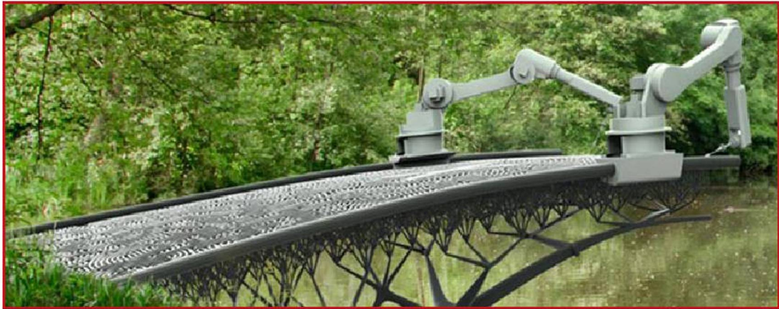
Xây cầu bằng công nghệ in 3D
