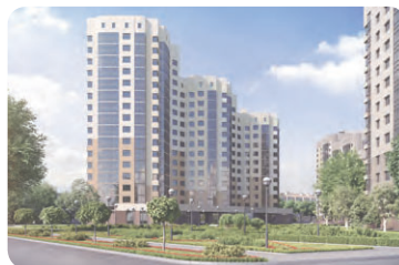
Hình 1.7. Nhà ở chung cư
