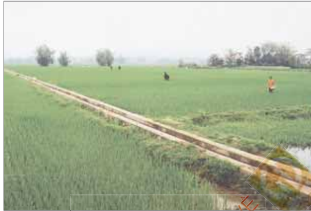
Hình 7.1. Kênh mương nội đồng đã được kiên cố hoá
