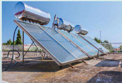
Hình 15.2 Bình nước nóng năng lượng mặt trời
