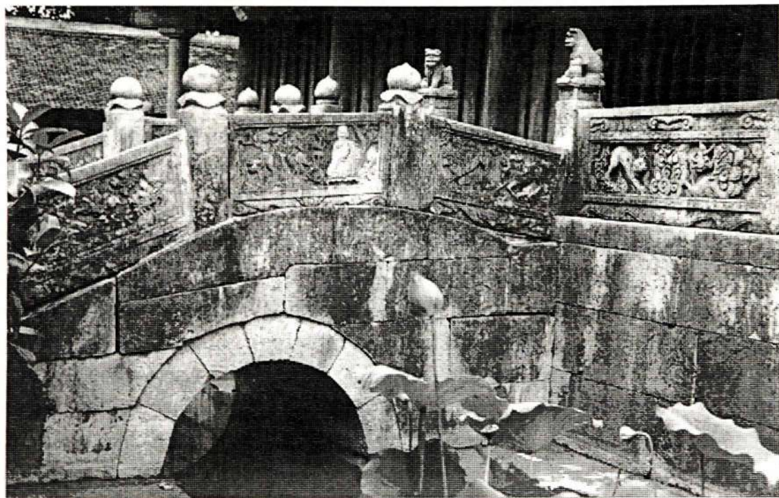
H24: Kiến trúc cầu đá
