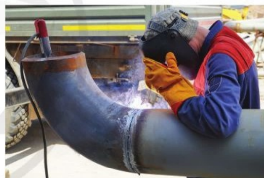
Hình 3.9. Hàn đường ống
