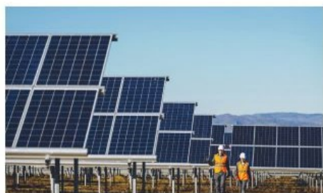
a) Nhà máy điện Mặt Trời
