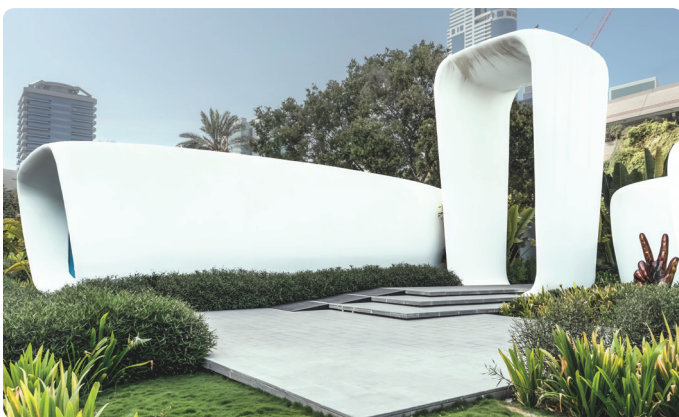
Hình 14. Một phần toà nhà ở Đu-bai (Các Tiểu vương quốc A-rập Thống nhất) được xây dựng bởi máy in 3D
