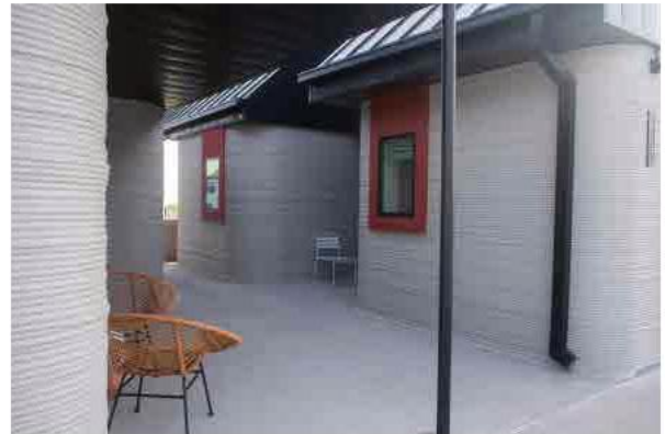
b) Tường nhà được in 3D
