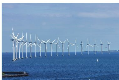
b) Nhà máy điện gió
