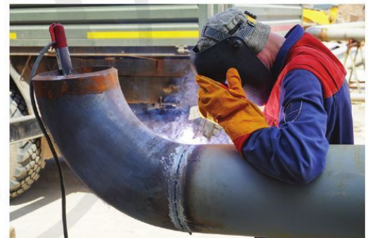
Hình 3.9. Hàn đường ống
