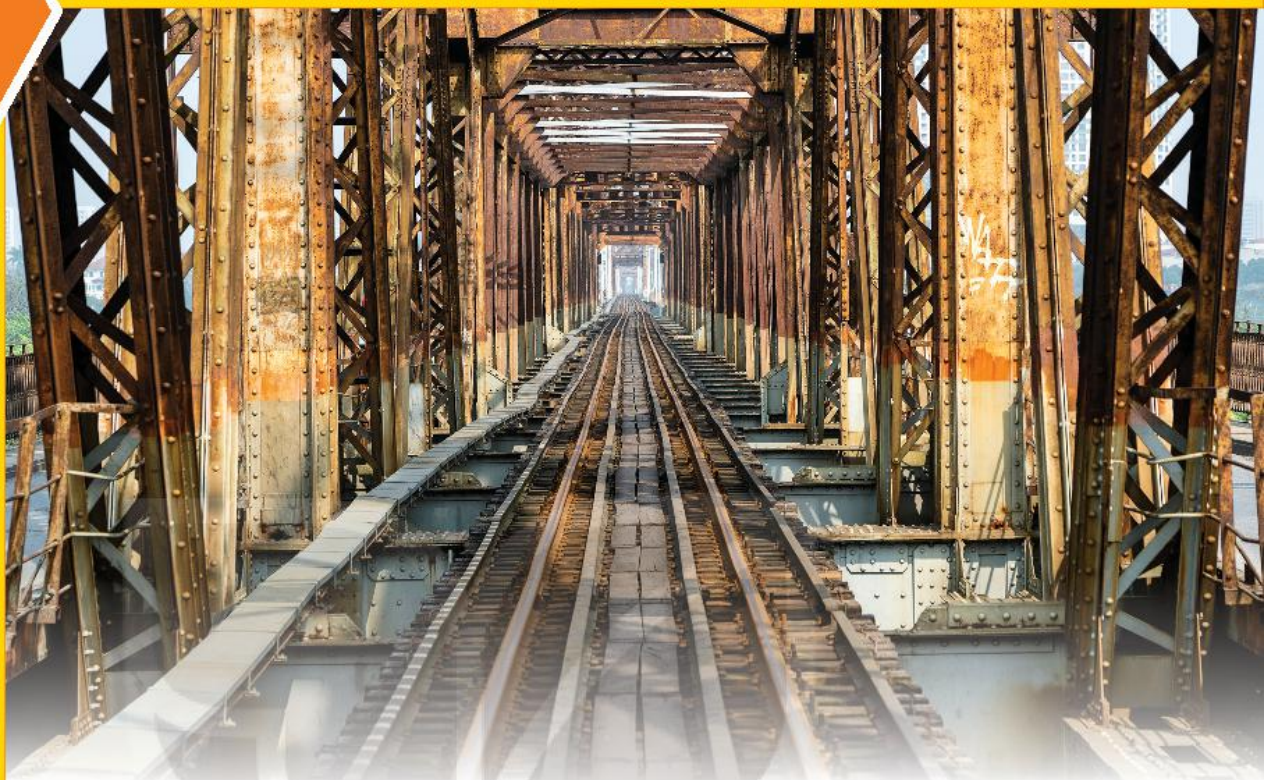
Kim loại bị gỉ do xảy ra các phản ứng oxi hoá – khử
