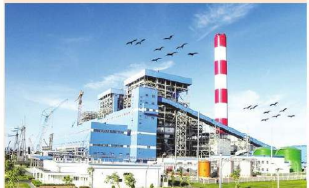
Nhà máy nhiệt điện
