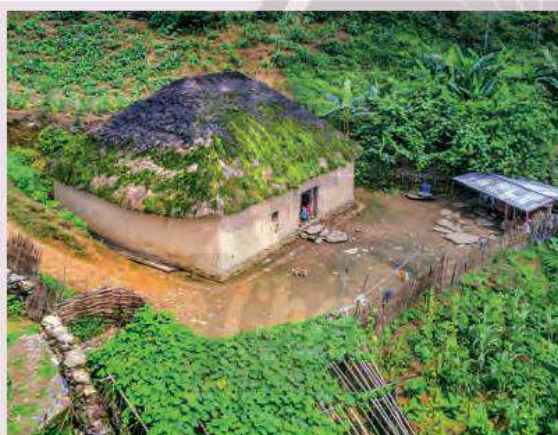
1. Nhà trình tường ở Lào Cai
