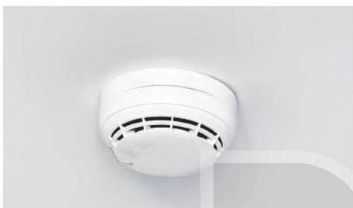
c) Cảm biến phát hiện khói ứng dụng cảnh báo cháy nổ
