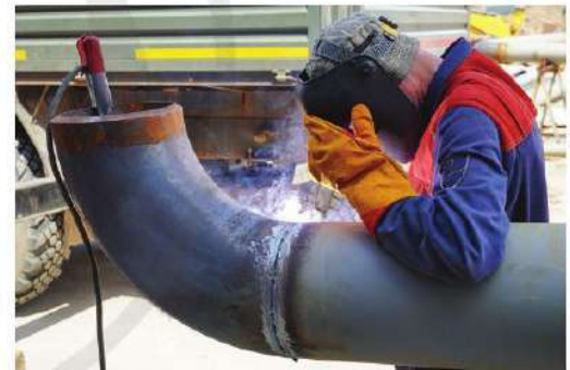
Hình 3.9. Hàn đường ống
