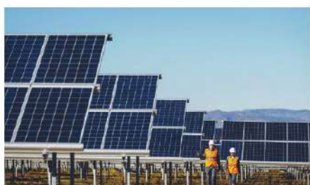
a) Nhà máy điện mặt trời
