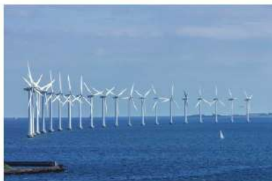
b) Nhà máy điện gió
