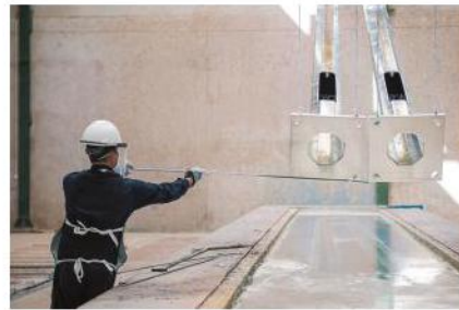
b) Xử lý bề mặt cột điện
