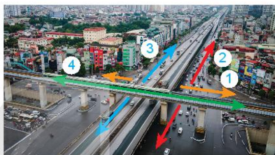
Hình 4.13. Tuyến đường bộ (1, 2), tuyến đường vành đai trên cao (3), tuyến đường sắt trên cao (4)
