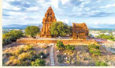
Hình 4. Đền tháp Pô Klong Ga-rai (Ninh Thuận)
