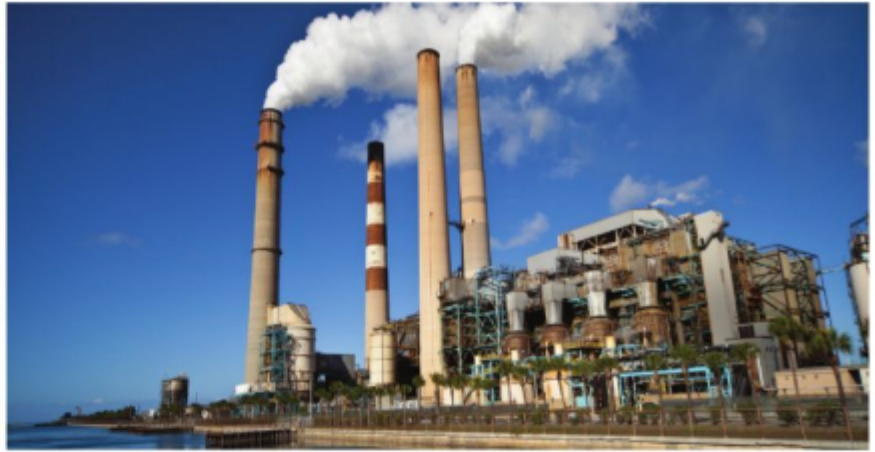
Hình 12.6. Nhà máy nhiệt điện
