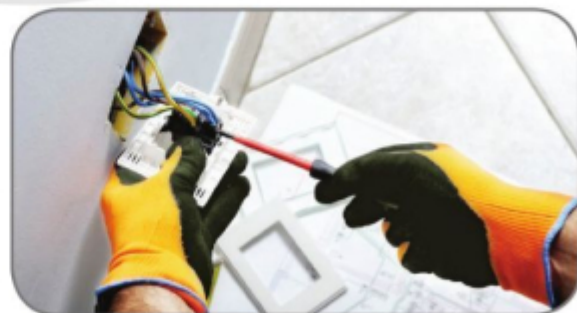
Hình 11.2. Sửa chữa mạch điện
