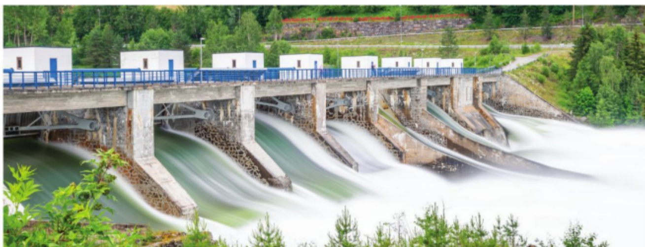
Hình 12.5. Nhà máy thủy điện
