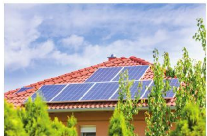
Hình 5. Nhà có sử dụng pin mặt trời
