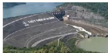
Hình 1.2. Nhà máy thủy điện Hoà Bình
