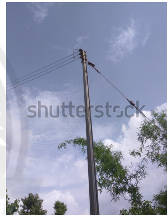
▲ Hình 14.12. Dây thép giữ cột điện
