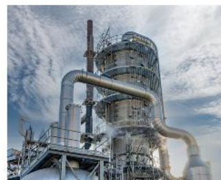
▲ Cột chưng cất phân đoạn hoá dầu
